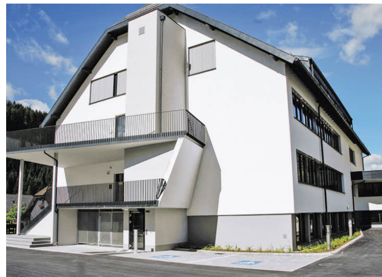
Ein Jahr wurde saniert, jetzt zum Schulstart ist alles fertig. BILD: PERNER
